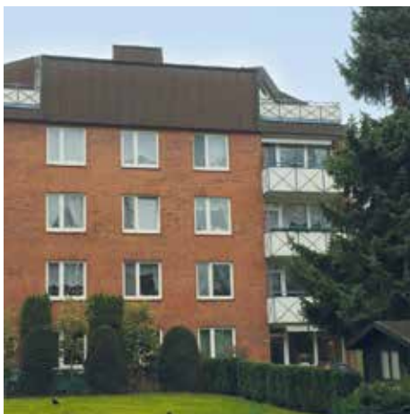
Vor Beginn der Modernisierungsmaßnahmen
