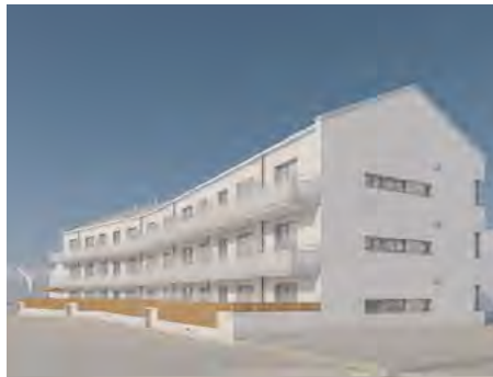
Ansicht von der Einfahrt ins Einkaufszentrum
